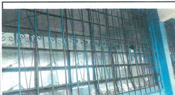
Foto 3: Estas balcones se han deteriorado, donde se les ha caído piezas por lo que es necesario darles un mantenimiento completo.
