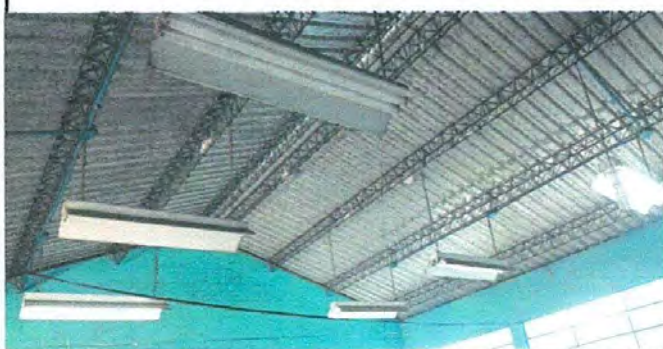
Foto 1: En algunas aulas las lamparas se han quemado por lo que se deben de sustituir.
