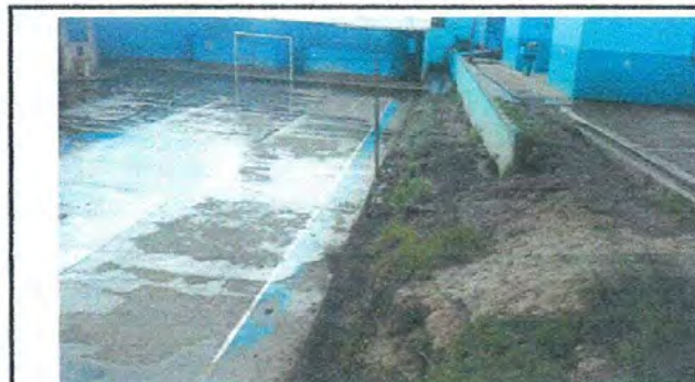
Foto 4: En este parte de la entrada a las aulas de de tierra y en epocas de lluvia se pone muy resbaloso ocasionando daños a los estudiantes por lo que es de urgencia ponerle torta de concreto.
