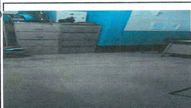
Foto 5: Este es la dirección del centro educativo y su piso es de torta de concreto pero con el tiempo se ha deteriorado por lo que se debe de sustituir por piso de cerámica.
