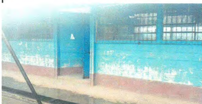
Foto 2: Todas las se mantienen de esta forma donde las paredes especialmente el exterior se ha despintado por lo que se debe de pintar.
