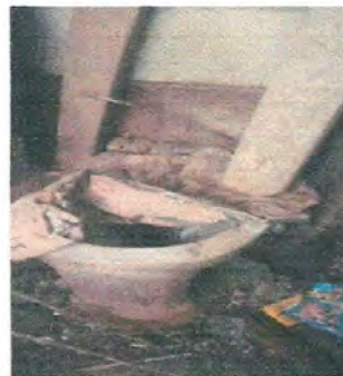
Foto 4: Actualmente hay un modulo de baños que son de letrina pero en desuso por lo que se van a sustituir por inodoros lavables.
