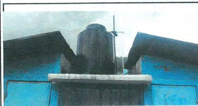
Foto 5: Hay dos Rotoplas que fueron colocados desde que fueron contruidos los modulos de baños pero se colocó mal la entrada y salida de agua, además de eso se han detriorado algunas piezas por lo que se
