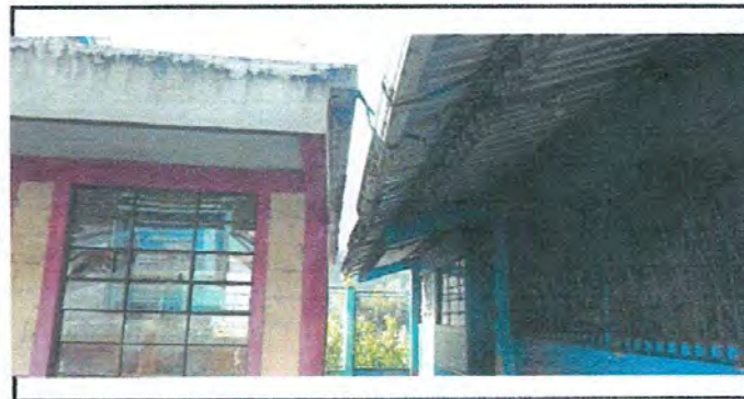
Foto 6: Todas las aulas tienen recoleccion de aguas a través de canaletas de pvc pero en algunas partes se han quebrado o caído por lo que se debe de sustituirlos
